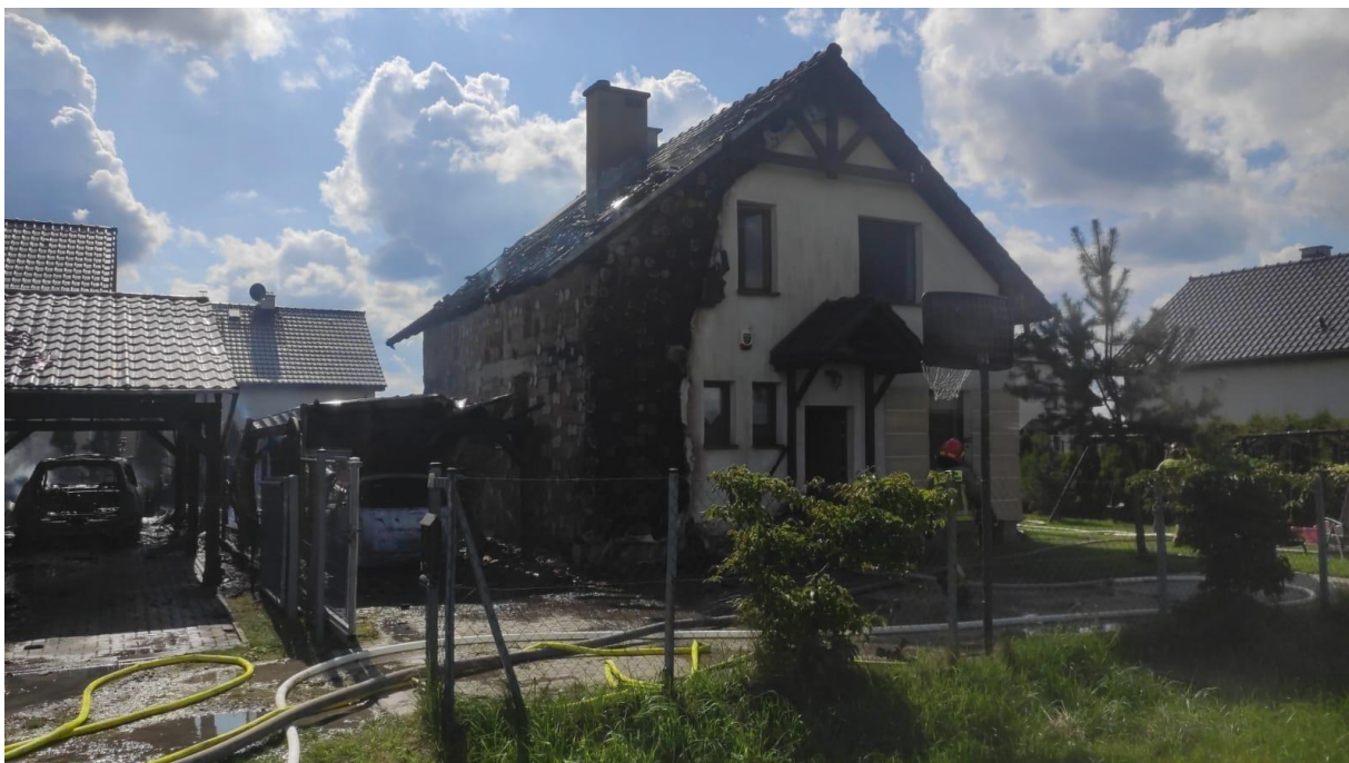
Fotografia 9 Pożar wiat w Sośnicowicach, 03.09.2023 r.
