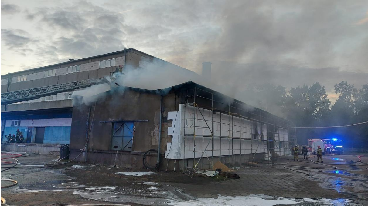
Fotografia 10 Pożar hali magazynowej, Gliwice ul. Portowa 10, 13.10.2023
