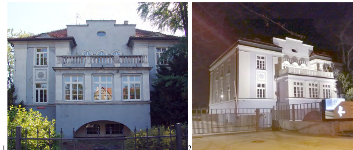
1. Budynek przed remontem w 2012 r. , fot. Ewa Pokorska-Ożóg 2. Budynek po remoncie w 2017 r., fot. Ewa Pokorska-Ożóg
